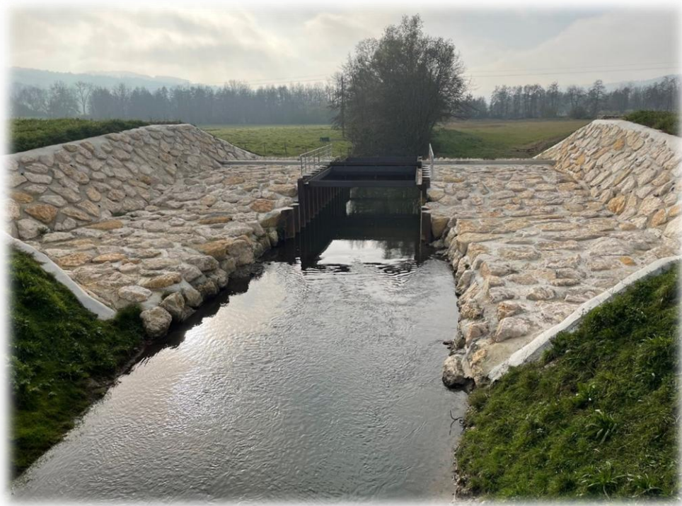
Barrage écrêteur Saint Ondras – Le Passage
