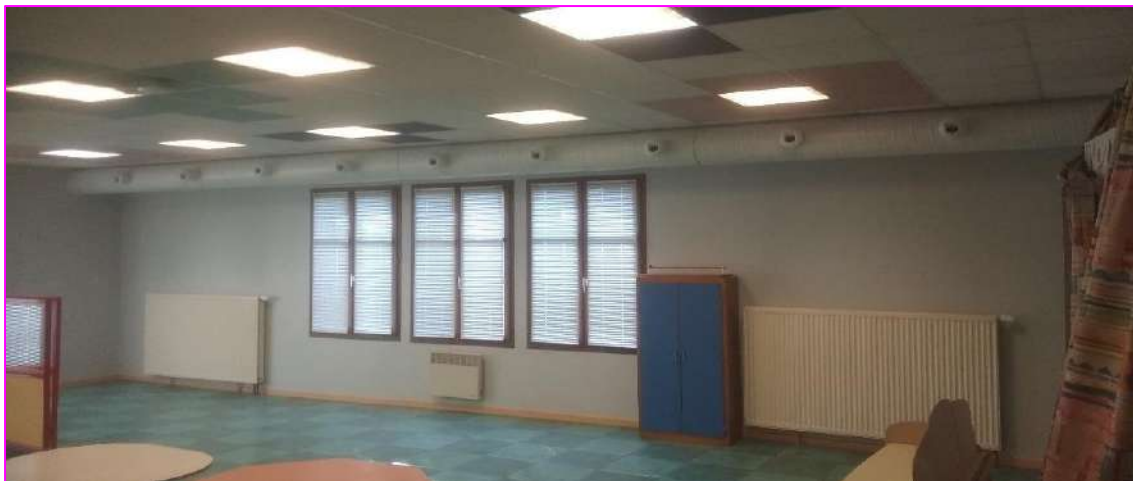
Installation de la VMC dans la salle d'évolution de la maternelle.
