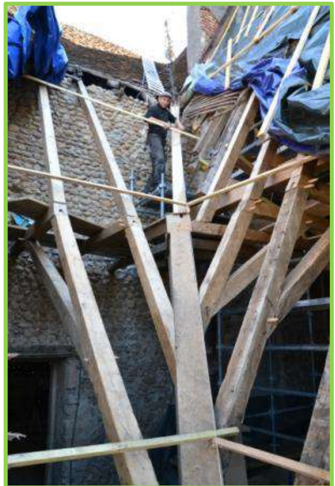
Poutre centrale de la noue
