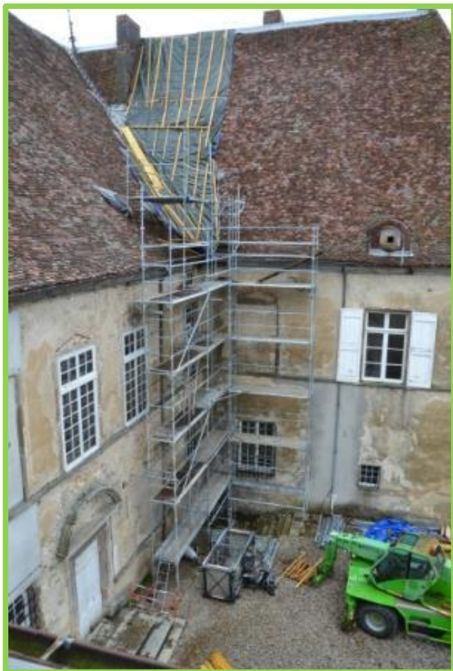
Vue extérieure du chantier
