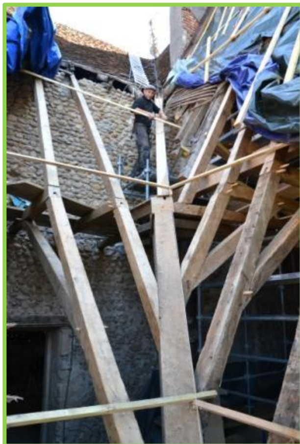
Poutre centrale de la noue
