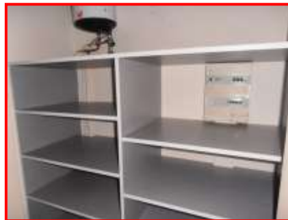
Fabrication et pose d'étagères dans le placard du secrétariat de Mairie.
