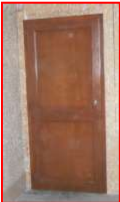
Fabrication et pose de 2 blocs-portes aux greniers du bâtiment mairie : Coût de la fourniture : 233,69 € TTC.
