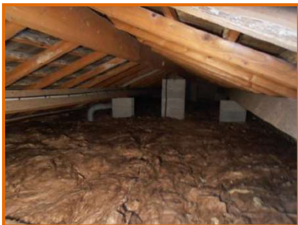
Isolation des combles vestiaires
