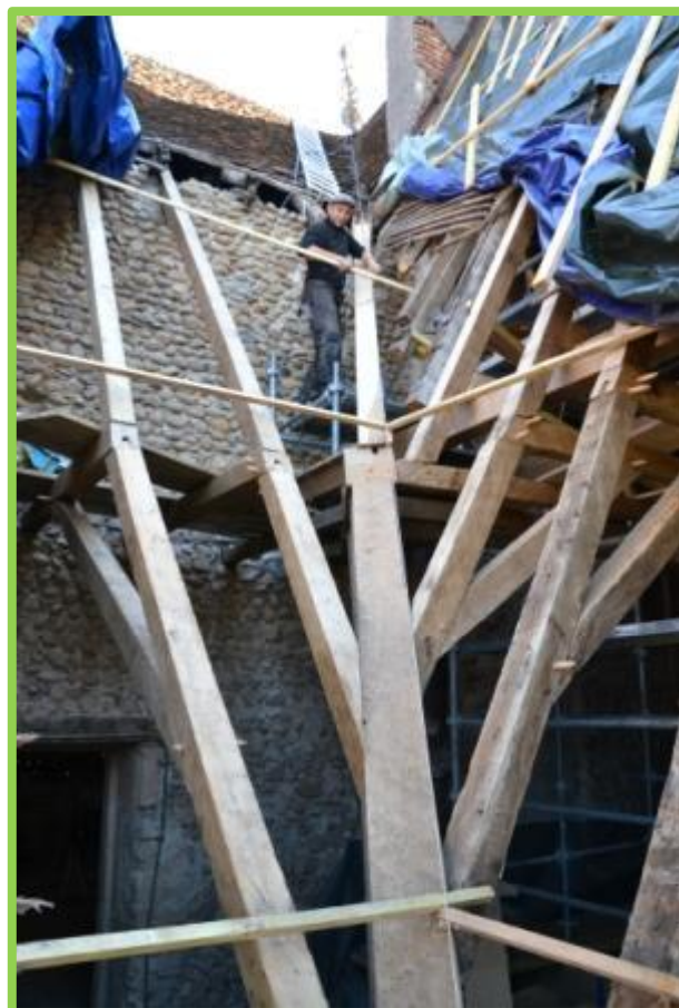
Poutre centrale de la noue
