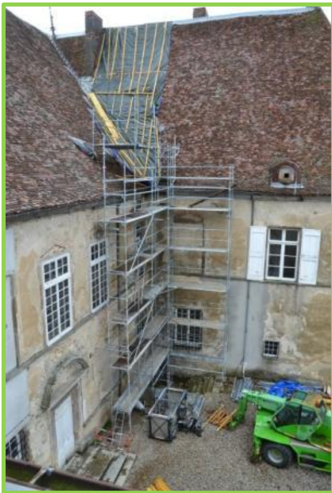
Vue extérieure du chantier
